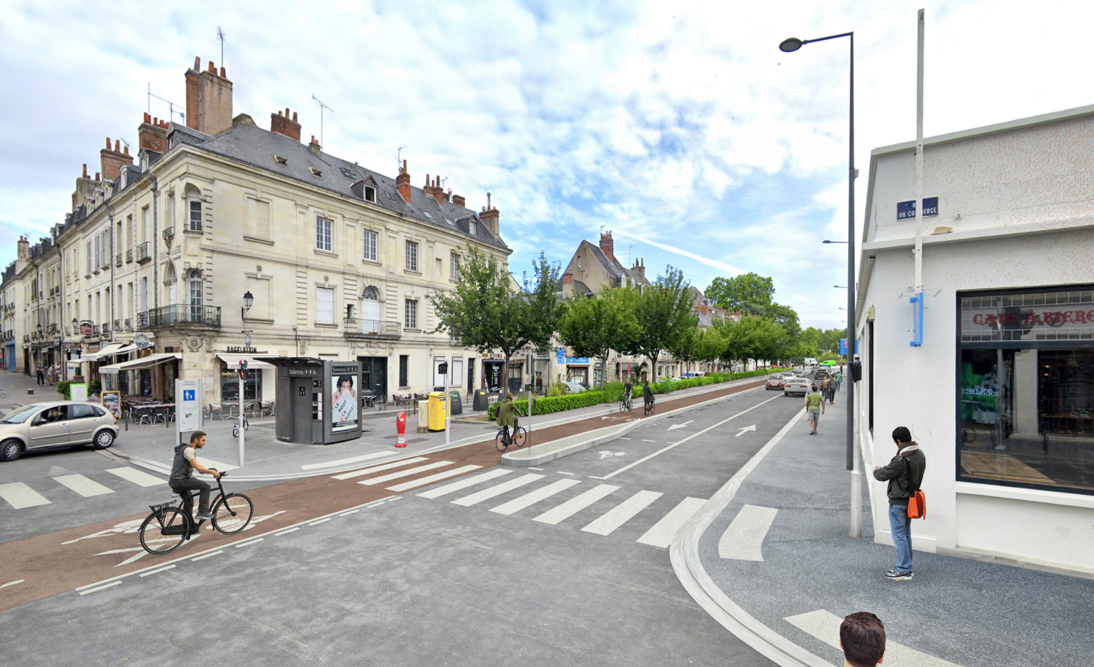
Finis les coups de peinture ! À partir de 2024, les aménagements cyclables de Tours répondent à un référentiel technique assurant capacité, confort et sécurité pour les cyclistes ! (Image non contractuelle © Tours Métropole Val de Loire)
