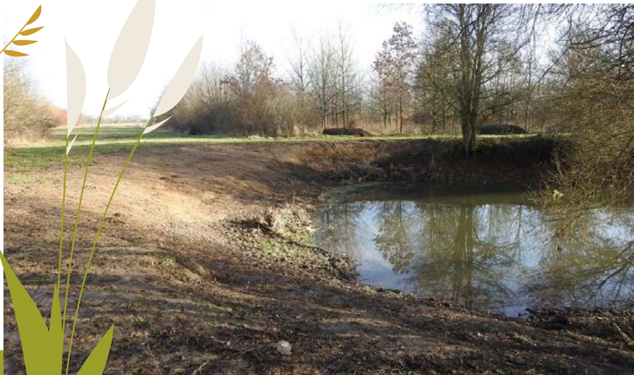
Photo après travaux de restauration de la mare de la Cousinerie.
