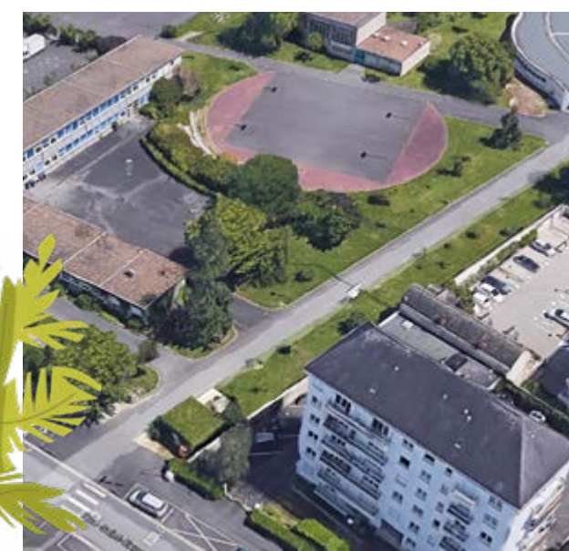
Le jardin Saint-Exupéry avant la transformation.
